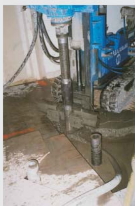
Усиление фундамента высотного здания микросваями ТИТАН 103/51 в сейсмоактивной зоне в Берклей, США
