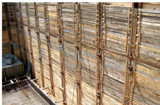
Анкерование „Берлинской стены“ в два яруса в Дрездене, Германия
