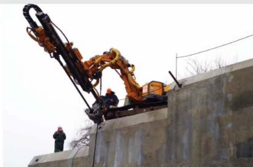
Крепление ж/б - опорной стелны анкерными сваями ТИТАН в Сочи, Россия
