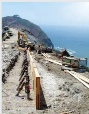
Свайный фундамент защитной стенки вдоль хайвея № 1 в США
