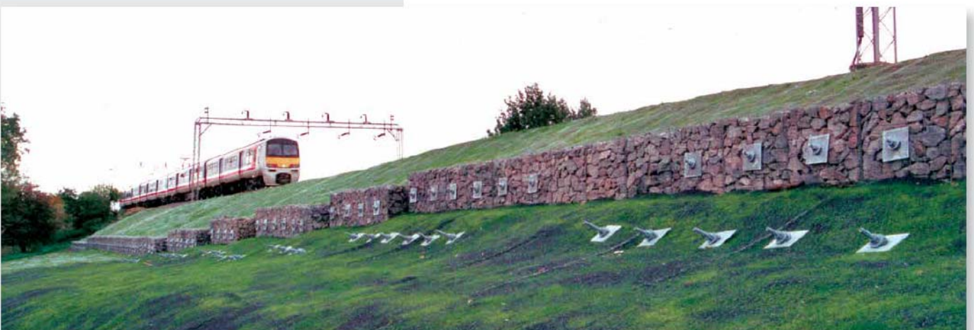
Крепление ж/д насыпи стальными сетками, габионами и анкерными сваями ТИТАН вдоль линии „Soulbury Road“, Великобритания
