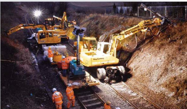
Крепление ж/д насыпи стальными сетками, габионами и анкерными сваями ТИТАН вдоль линии „Soulbury Road“, Великобритания
