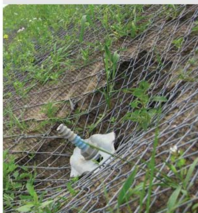
Нагельное крепление и облицовка торкрет-бетоном портальной стенки тоннеля Лалики в Польше
