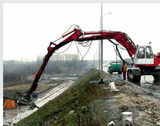
Навесные буровые мачты на обычной строительной технике для бурения малых и средних типоразмеров от ТИТАН 30/16 до ТИТАН 52/26, производителей TEI Rockdrills, Morath итд.
