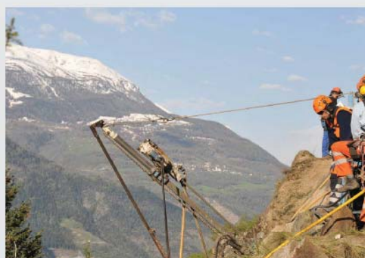
Противообвальное крепление скалы нагелями ТИТАН 30/11 под железной дорогой, Швейцария
