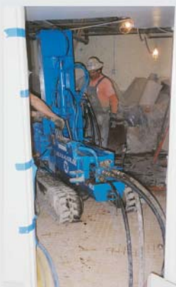
Усиление фундамента высотного здания микросваями ТИТАН 103/51 в сейсмоактивной зоне в Берклей, США
