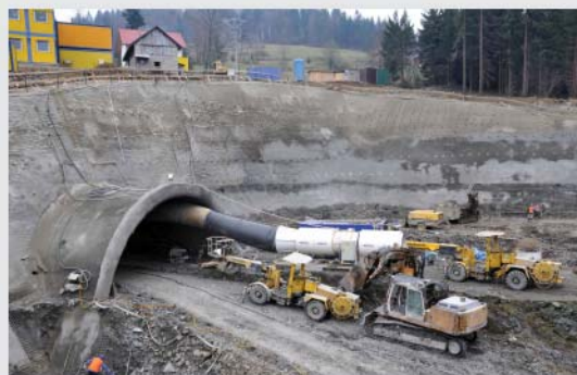
Нагельное крепление и облицовка торкрет-бетоном портальной стенки тоннеля Лалики в Польше
