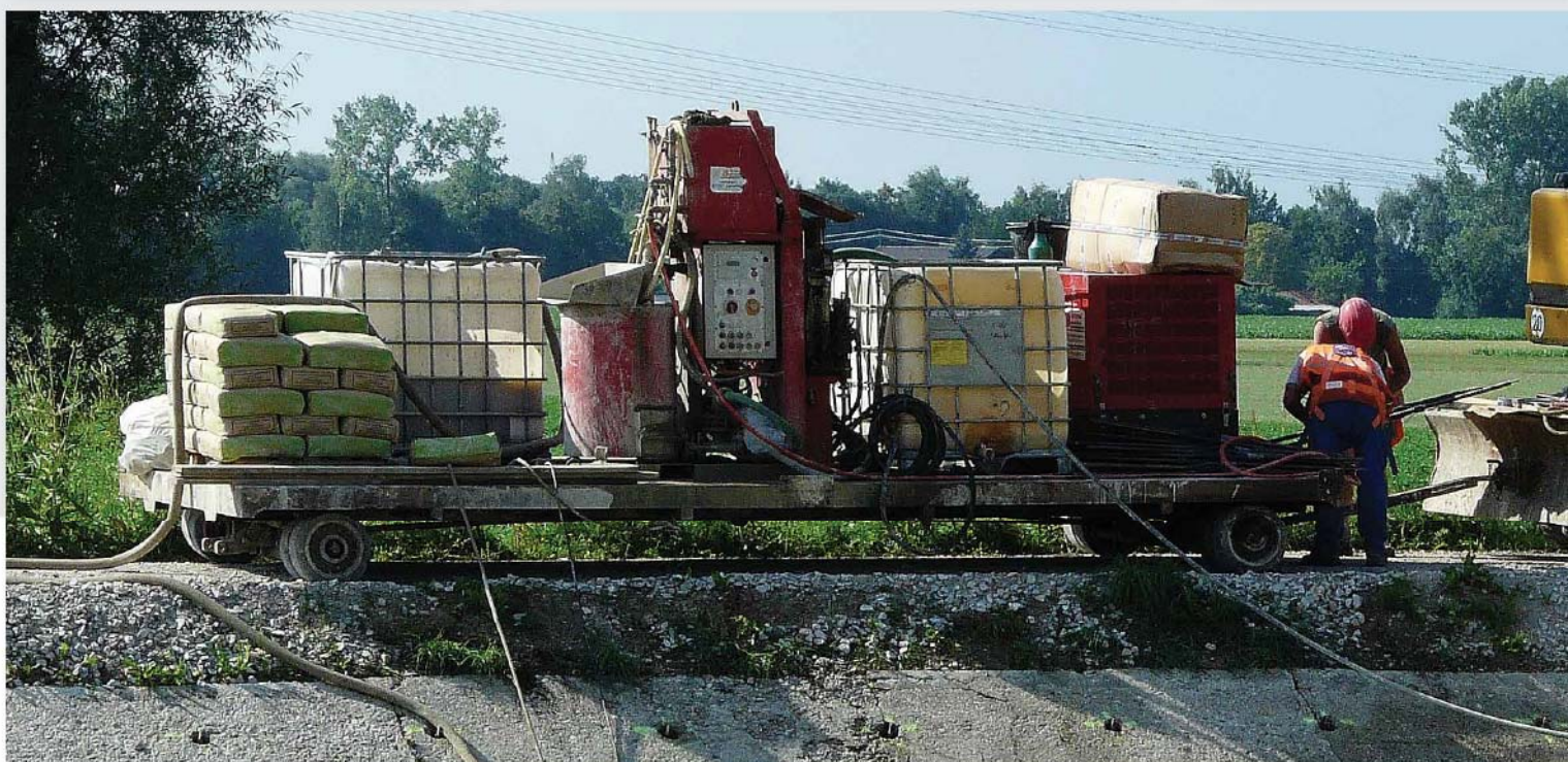
Типичная стройплощадка: экскаватор с навесной мачтой насосная станция с расходными материалами на прицепе.
