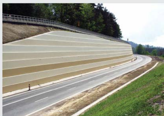
Крепление склона нагельным способом и облицовка ж/б панелями вдоль дороги С1, Миловка, Польша
